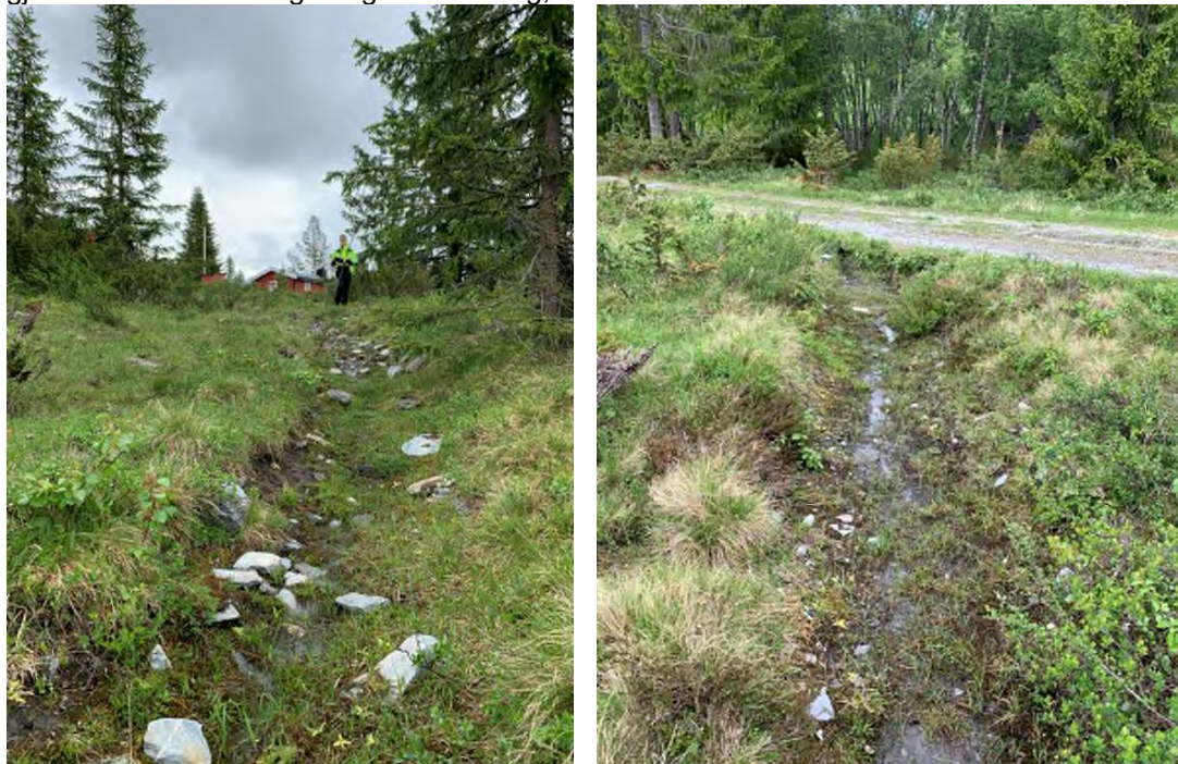
Figur 8. og Figur 9. Terrenggrøft mellom stikkrenne nr. 8 og 9 (jfr. Figur 7)
