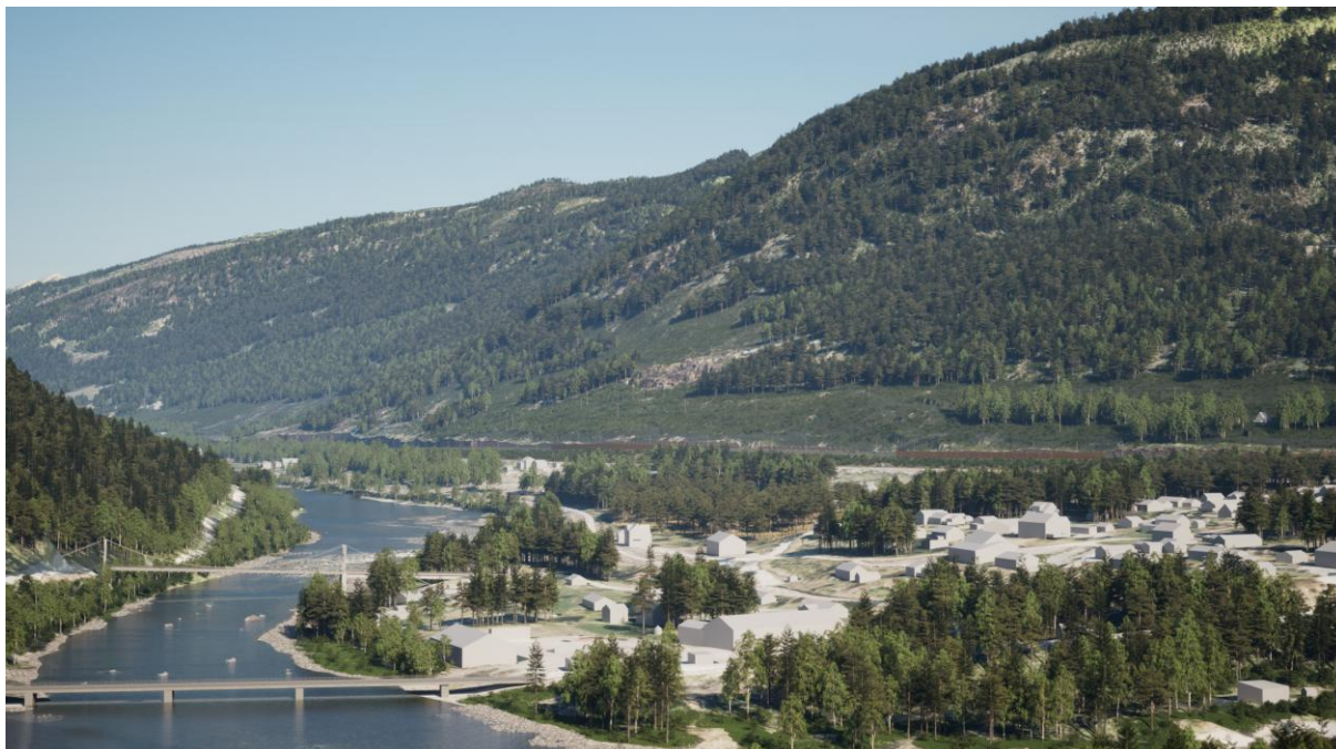
Figur 4-1 Illustrasjonen viser bergskjæring mellom Sjøa og Nordre-Eide sett fra baksida ved Sjøa.
