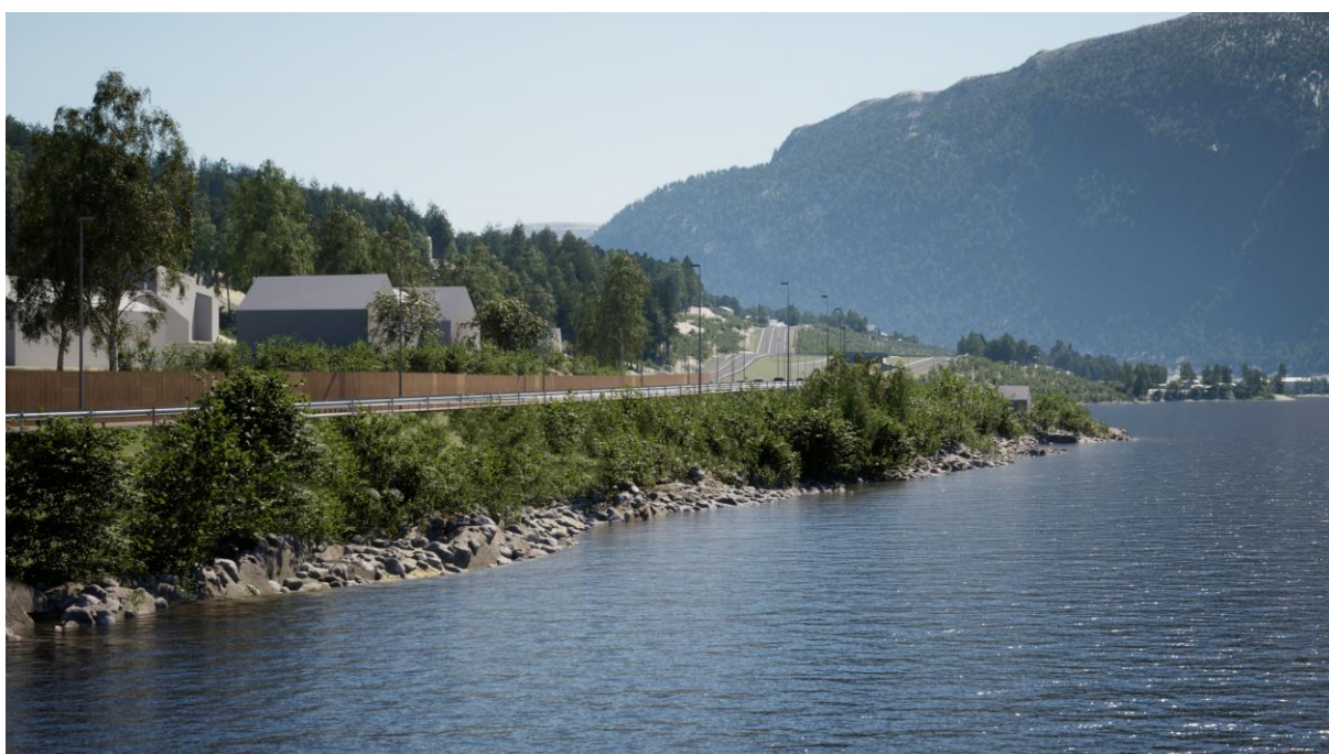
Figur 7-33 Illustrasjonen viser hvordan fyllingene til ny E6 strekker seg ned i strandsona til Lågen.
