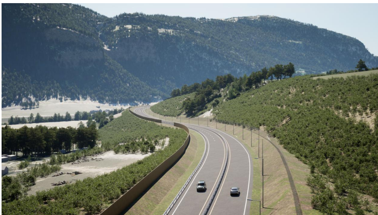
Figur 7-21 Illustrasjonen viser omfattende fyllinger og skjæringer i grusryggen som følge av tiltaket i alternativ 1I. Revegetering av de store terrenginngrepene vil over tid bidra til å redusere synligheten av tiltaket og gjenopprette silhuetten av åsryggen.
