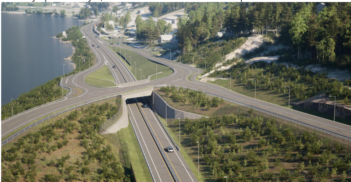
Figur 6-13 Illustrasjon av planskilt kryss med nordvendte ramper til/fra E6.
