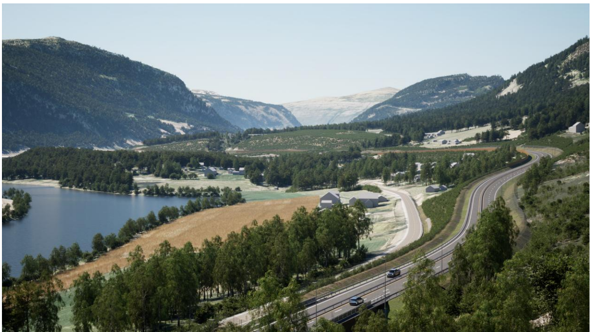
Figur 8-4 Illustrasjonen viser hvordan tiltaket i alternativ 1I vil ha en sterk visuell barrierevirkning gjennom delområde 3. Nytt veianlegg går høyere i oppe i lisen og inngrepet knyttet til dette alternativet vil bli noe mer eksponert i det overordnede landskapsbildet.
