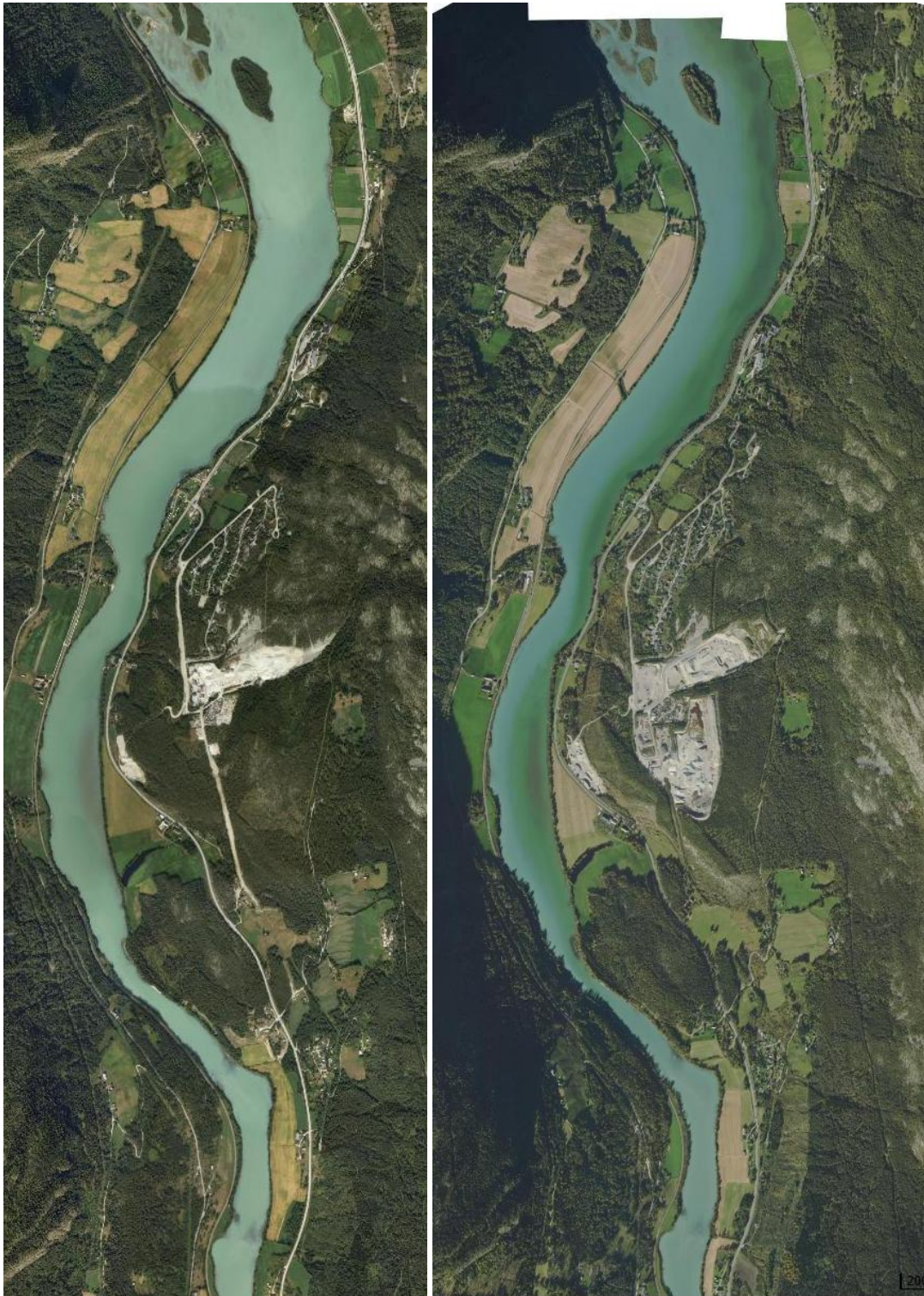
Figur 10-2 Flyfoto fra 2006 t.v. og 2024 t.h. Planområdet og tilleggende områder er i hovedtrekk noe endret i denne perioden, bl.a. med utvidelser av masseuttaksområder, trasehogsten og noe boligutbygging.
