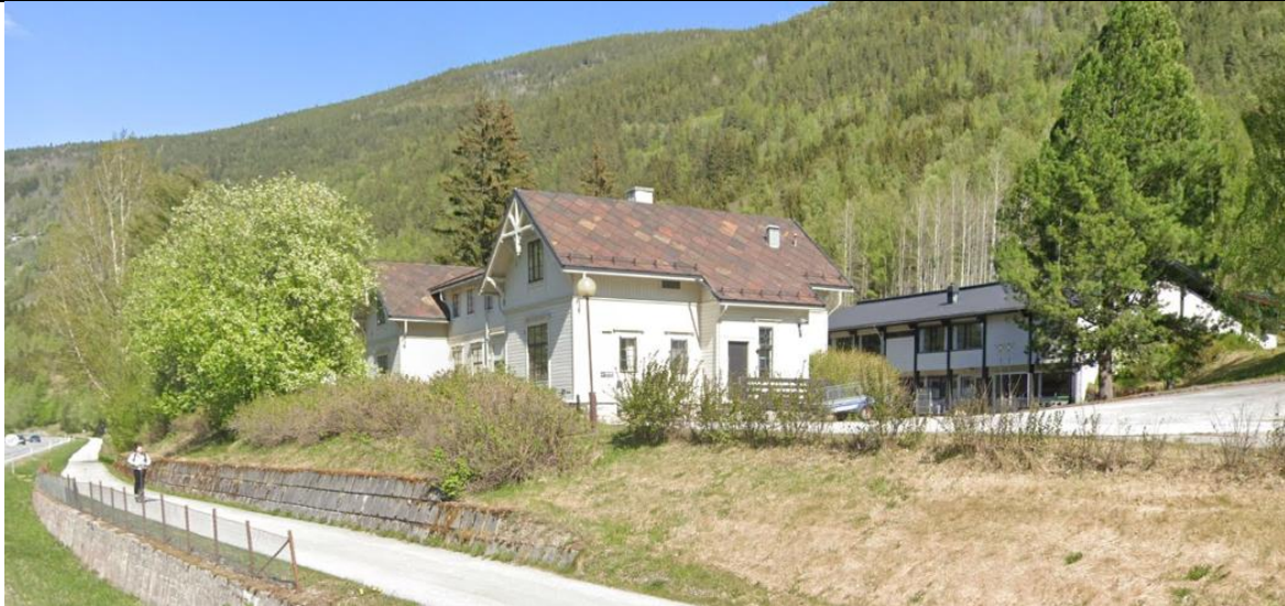
Administrasjonsbygget til Bredevangen fengsel. Kilde: Google maps.
