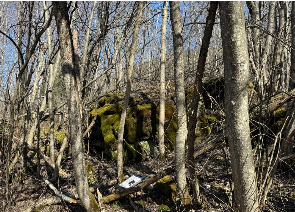
Figur 6-4: Blokk fra befaring utført 09.04.2025.
