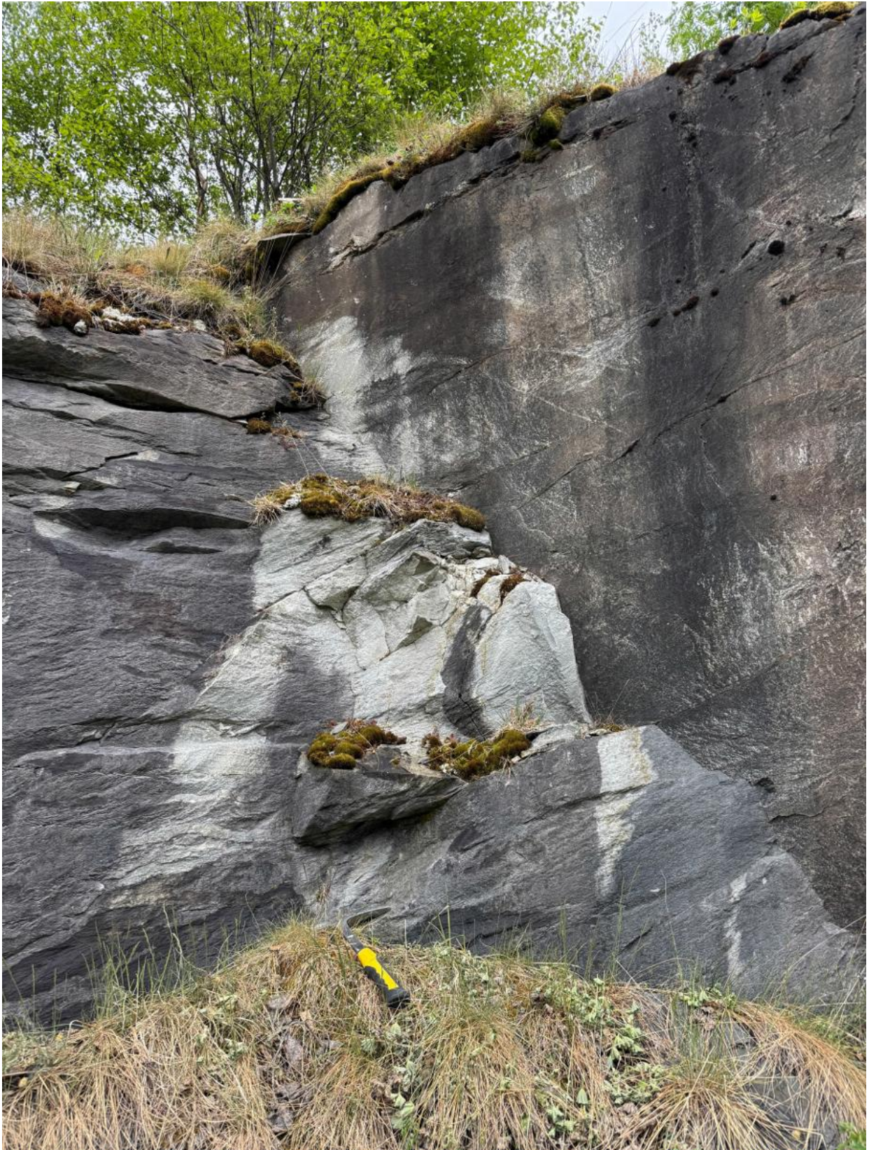
Figur 4-5 Kvartsitt i eksisterende bergskjæring langs E6 ved ca. profil 1950. Bildet er tatt mot øst.
