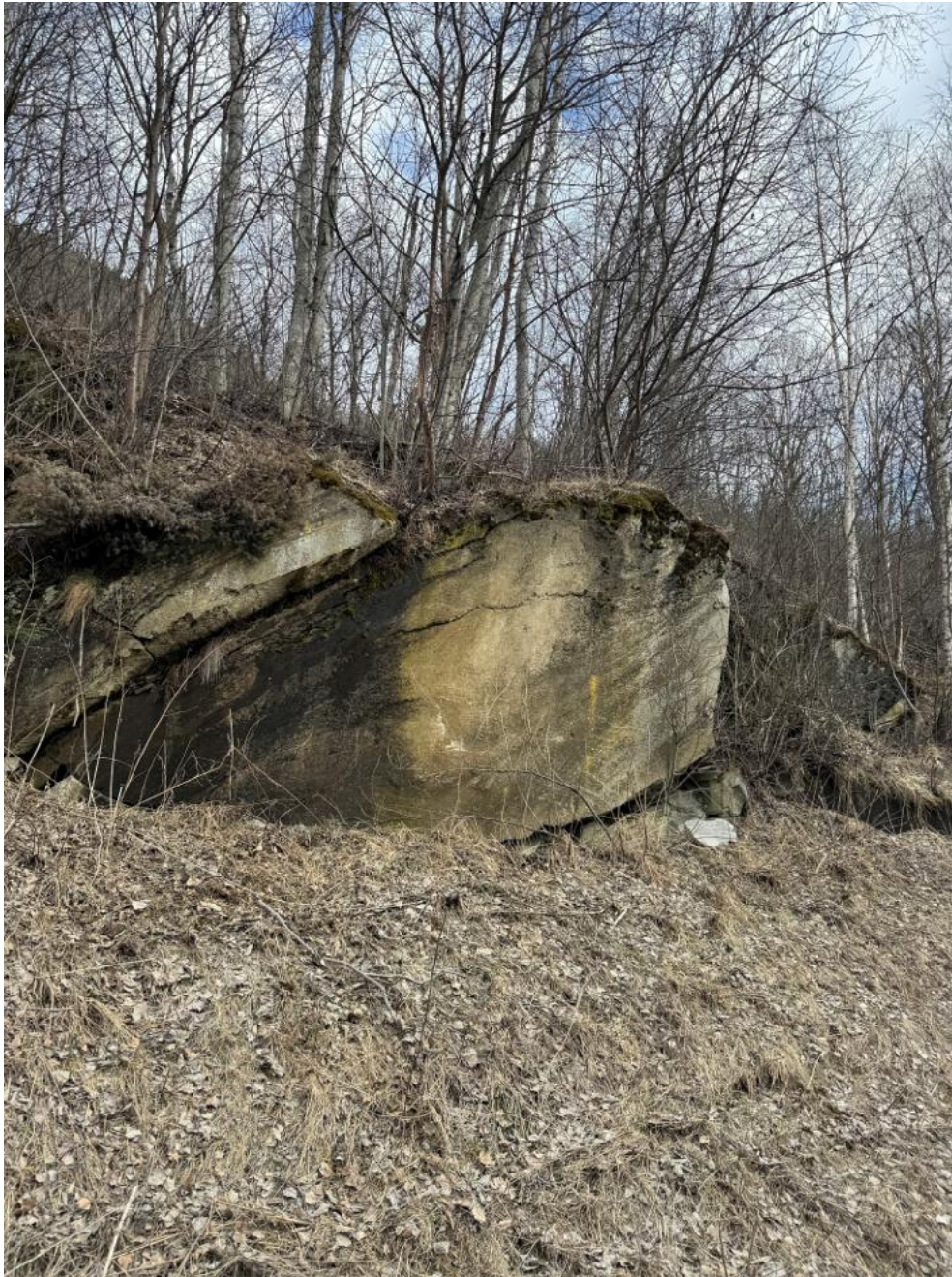
Figur 4-29 Karbonatlag i veksling med dolomitt ved ca. profil 2310 i eksisterende bergskjæring til E6. Gjennomgående sprekker/slepper med lavt fall som følger foliasjonen, eller lavere fall enn foliasjonen. Sprekkene er åpne, eller med leirfyll. Fall er inn i bergskjæringen.
