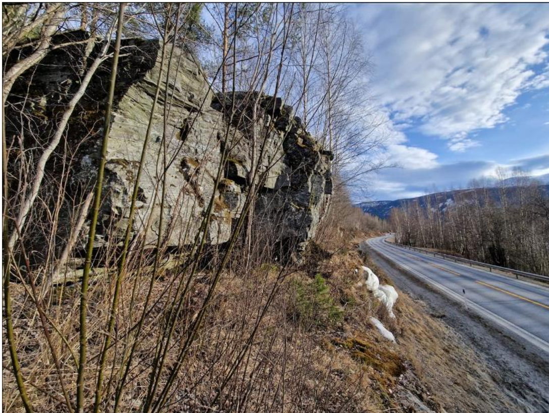
Figur 5-3: Store blokker med avløst berg over eksisterende E6 ved ca. profil 2640. Bilde er tatt mot sør.
