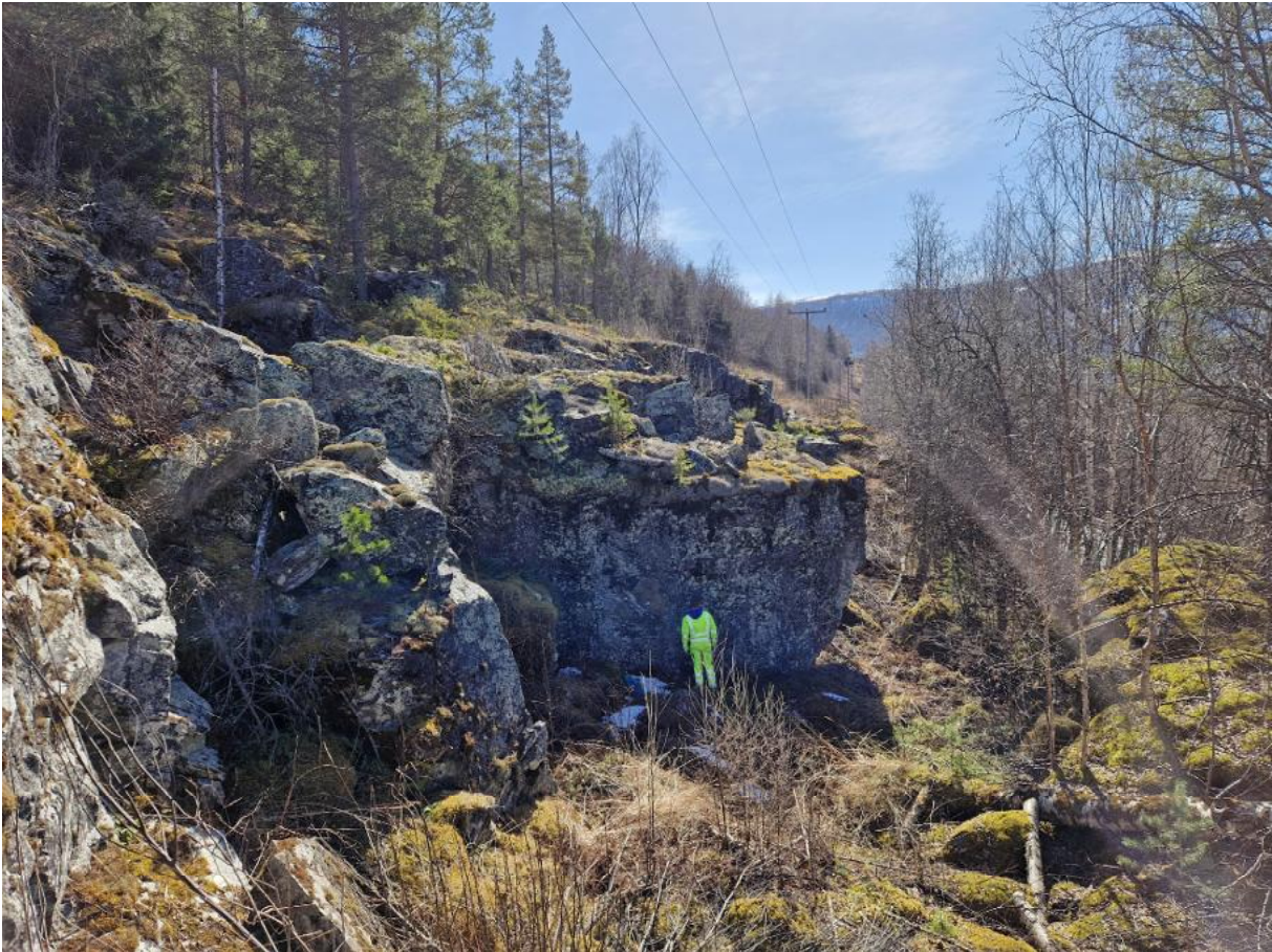
Figur 7-1: Større avløste blokker som vil komme i nærheten av kontur til ny bergskjæring ved ca. profil 2650.
