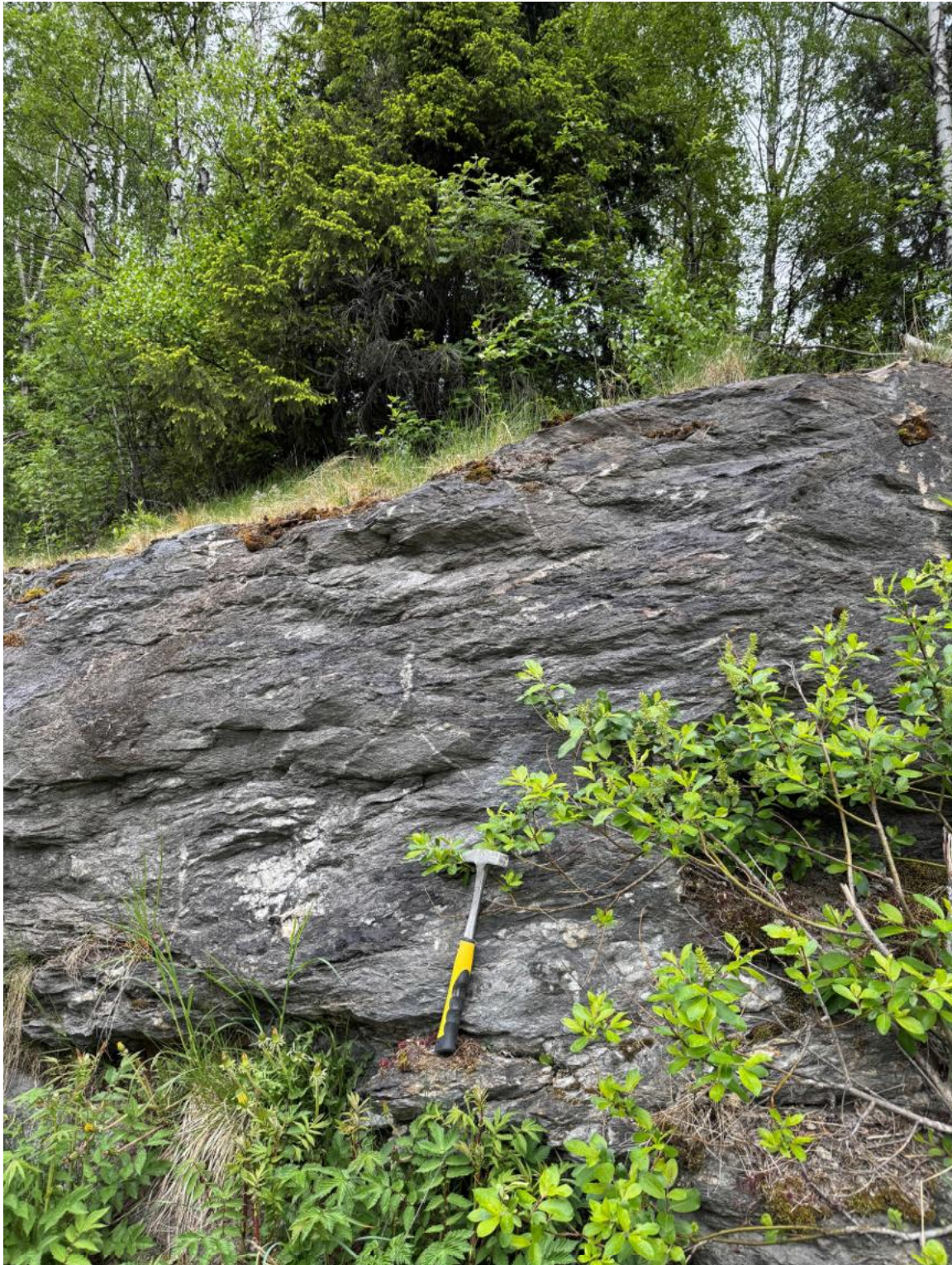
Figur 4-6 Bildet tatt ved ca. profil 1700 i eksisterende bergskjæring langs E6. Ut ifra NGU's berggrunnskart skal dette være diamiktitt. Bergarten har en grålig forvittringsflate med en mer grønnlig matriks. Flere karbonatboller og bånd, sammen med noen kvartsårer.
