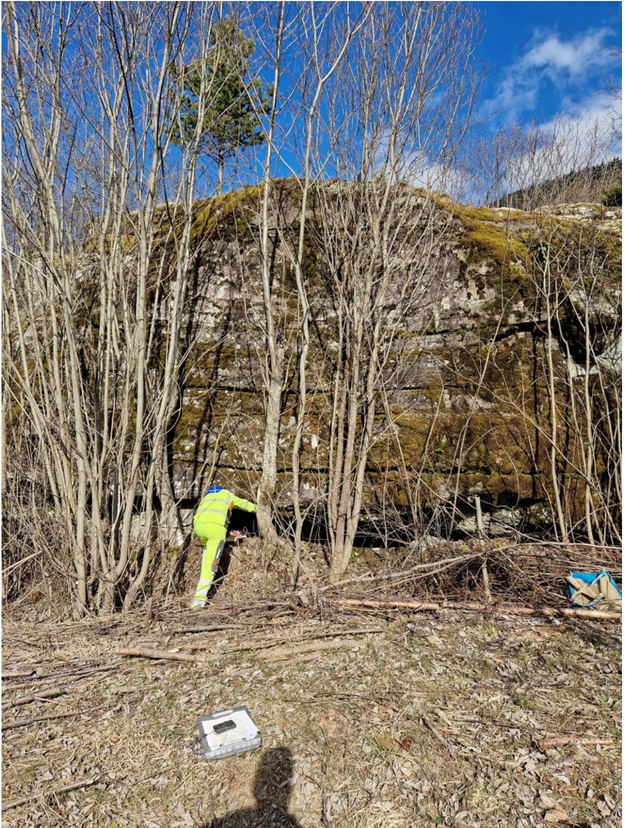
Figur 4-27: Typisk lagdeling ved ca. profil 1820. Bildet viser også en større åpen sprekk på omtrentlig 40 cm.
