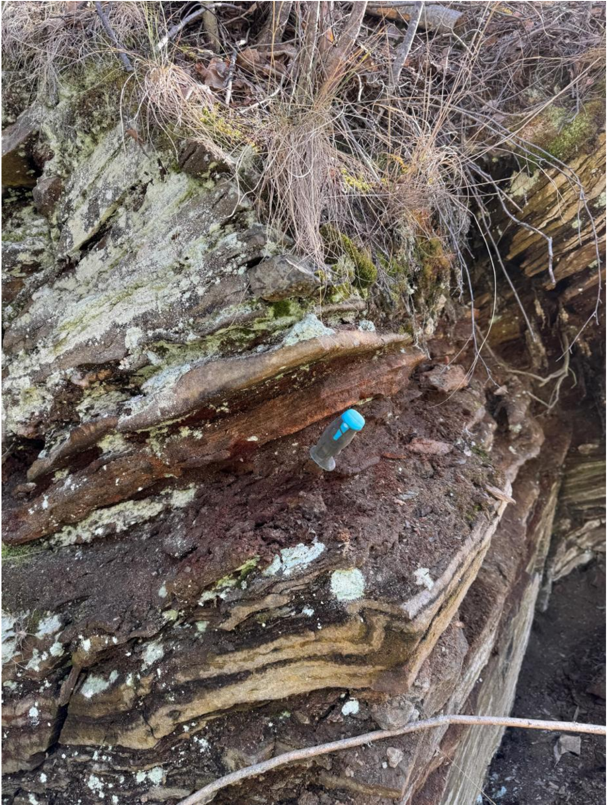
Figur 4-28 forvitret karbonatlag i veksling med dolomitt. Forvitret berg og tykkere lag leire registrert ved ca. profil 2600. Subhorisontale lag (strøk/fall på foliasjonssprekker 300/10).
