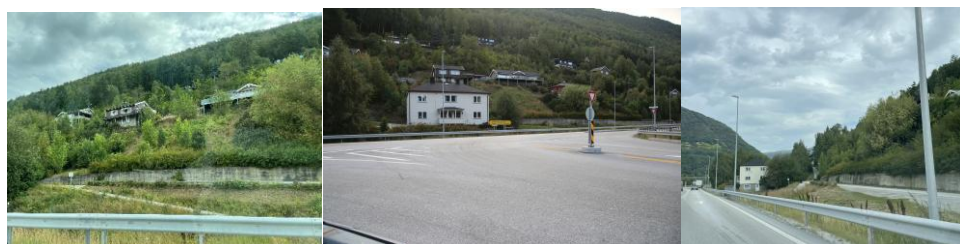
Figur 6-22 Bilder viser eksisterende kryss og gang- og sykkelvei og nærliggende boligområde.
