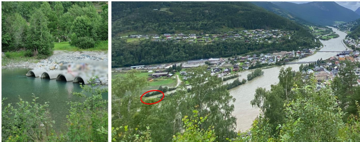
Figur 20 Betongkølverter i fylling/vadested til Ottbragdøya. Området er oversvømt under ekstremværet Hans. Foto fra Norconsult, 10. juli 2023 (venstre) og under ekstremværet Hans 9. august 2023 (høyre).
