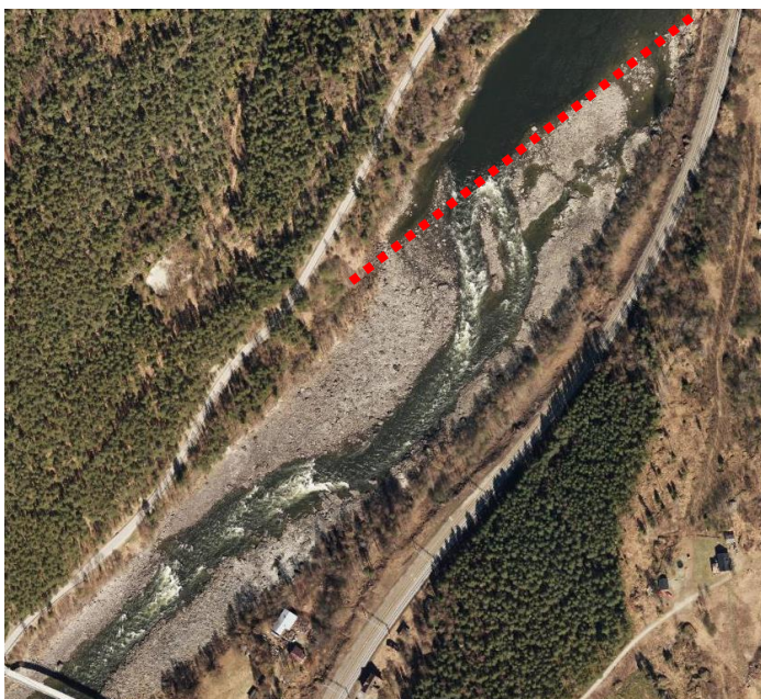
Figur 31 Stryk mellom Sjoa jernbanebru og Sjoa tettsted på lav vannføring. Rød, stiplet linje antyder naturlig terskel av stein som kan sees fra flyfoto. Foto fra www.norgebilder.no , flyfoto Midt-Gudbrandsdal 2017. Nederst i bildet vises bru over til Stasjonsvegen på Sjoa.
