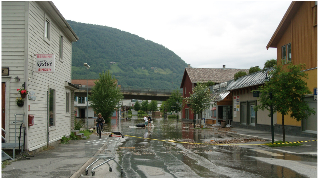
Figur 9. Otta sentrum, flommen i 2011. Foto: Line Brånå Bergum
