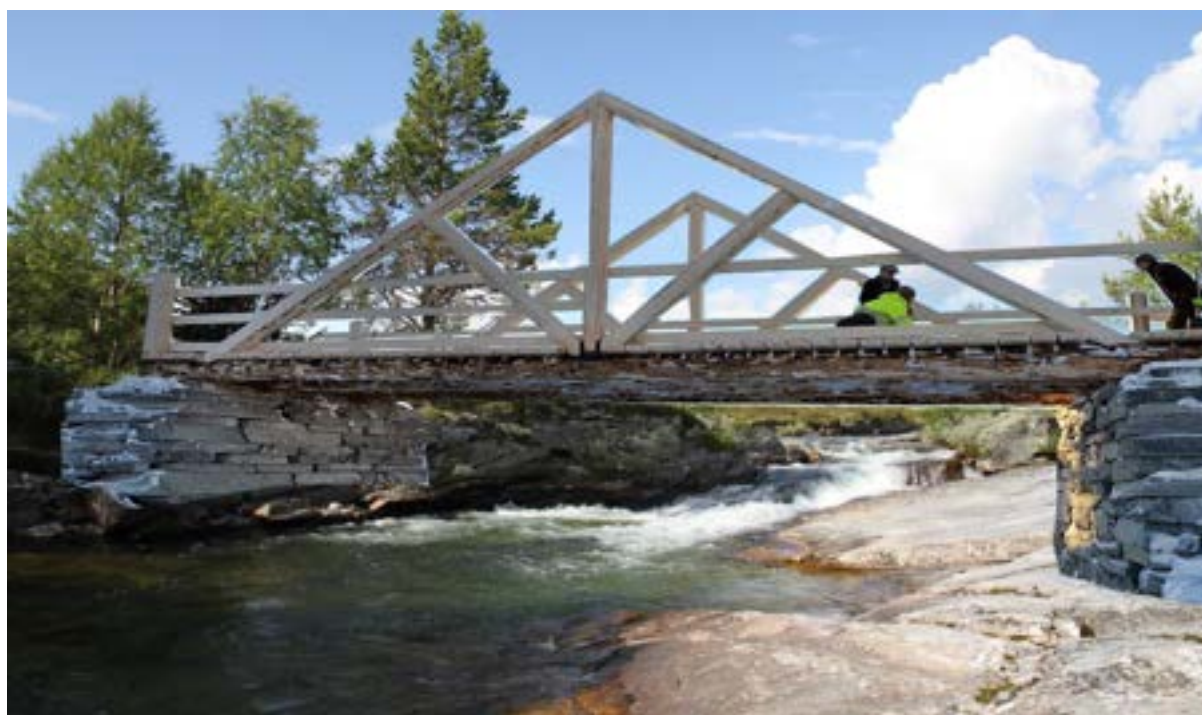
Fig. 3a: Eksempel med bro for kryssing av Ula bygget i tre (fotomontasje Terje Bekkemellom)
