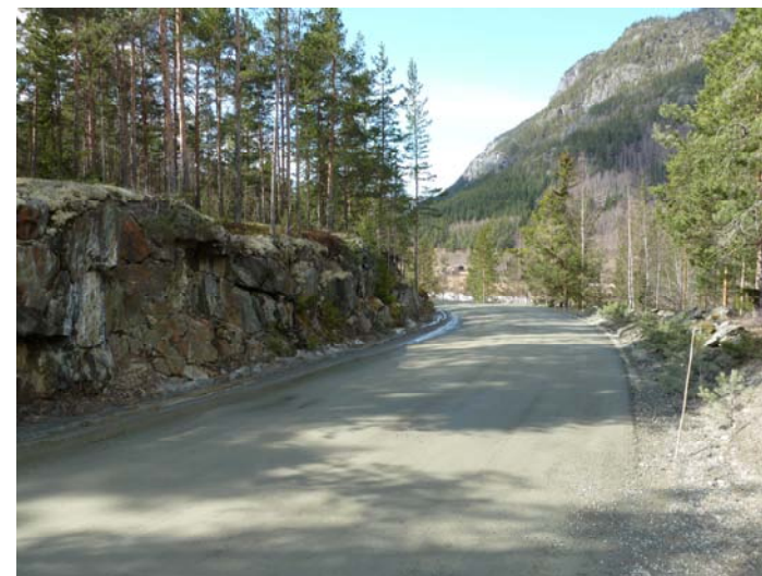
Fjellskjæring i sving ved prof. 5000
