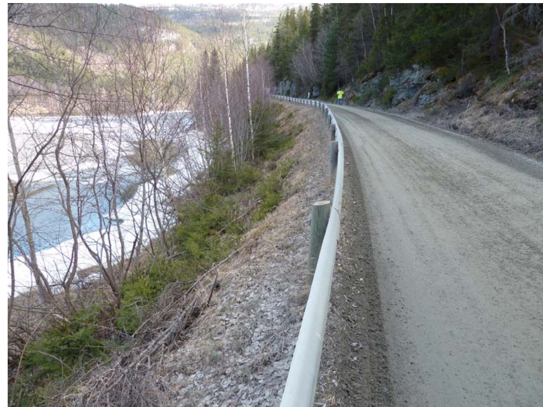
Eksisterende fylling ned mot Ottaelva.
