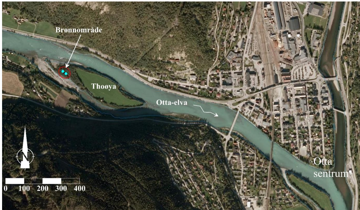
Figur 2. Flybilde med brønnområdet ved Thoøya vest for Otta sentrum.
