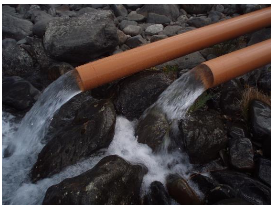
Figur 26. Utpumpet grunnvann ble ledet til elva for å hindre reinfiltrasjon.
