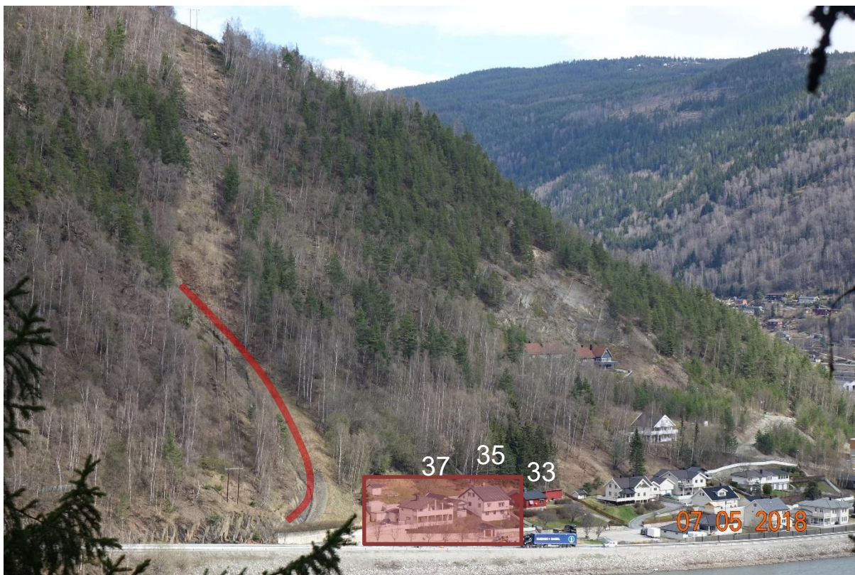
Figur 12: Ola Dahls gate 35 og 37 (merket med rød firkant) ble sikret med en ledevoll (merket med rød strek) etter skredhendelsen i 2013.
