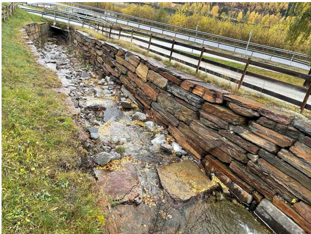
Figur 5: Steinsettingen i bunn av kanalen er avsluttet omtrent 20 meter oppstrøms kulvert under gangvei.
