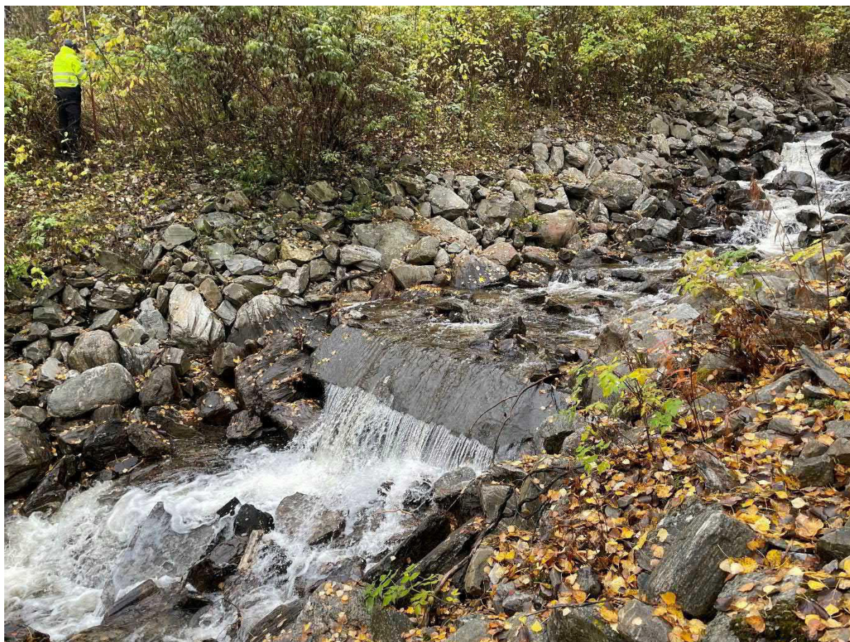
Figur 2: Erosjonssikring i Haredalsbekken oppstrøms gangbrua.
