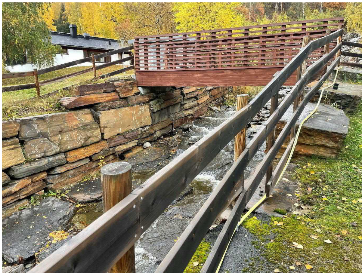
Figur 3: Gangbru mellom dagens sykehjem og den aktuelle eiendommen.
