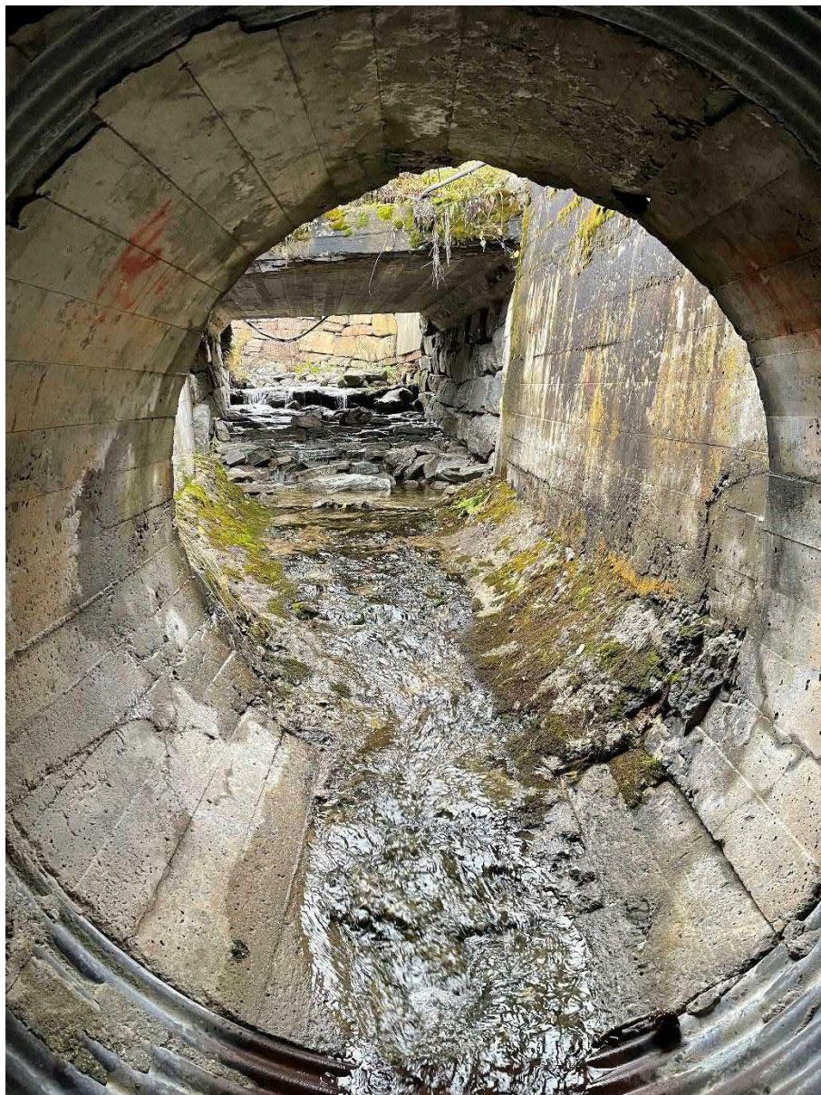
Figur 9: Betongtrau mellom kulvert og stikkrenne.
