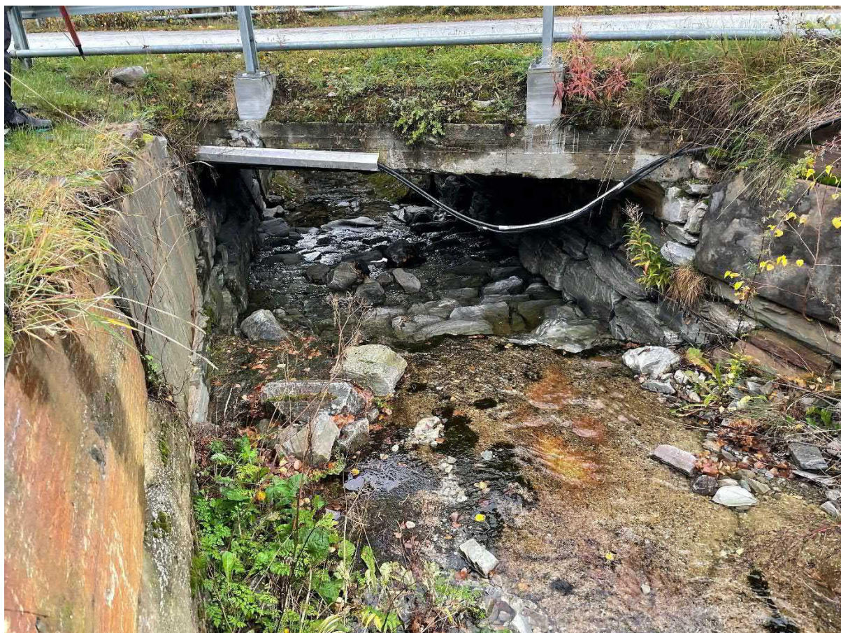
Figur 6: Kulvert under gangvei i Haredalsbekken.
