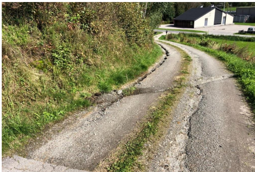
Figur 6-8. Gårdsvegen ovenfor Midtre Kleivrud. Det vil være teknisk utfordrende å plassere bekken i skråningen til venstre i bildet, så man har heller vurdert å benytte gårdsvegen, eller marka nedenfor gårdsvegen som foreslått trasé.
