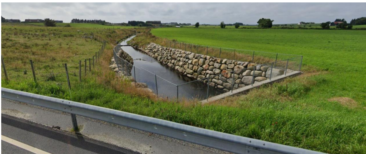
Figur 9-3 Horråna i Hå kommune. Innløpskonstruksjon der bekken ledes i lukket system under Vigrestad (Foto: Google maps, 2022).
