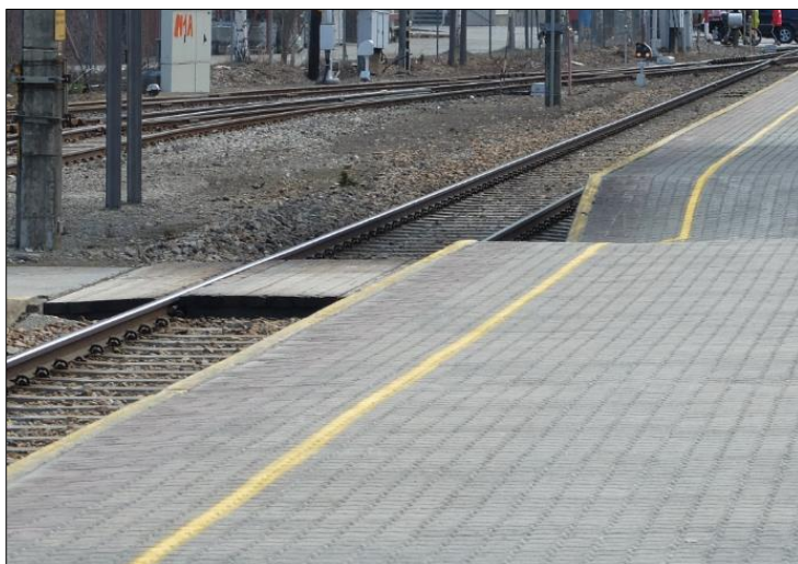
Figur 4-9 Krysning mellom plattformer i plan
