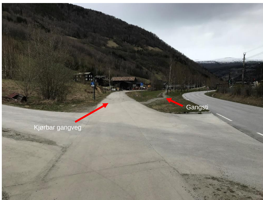
Figur 9-4. Krysset Selsvegen - Sygardsvegen. Sygardsvegen er skilta som kjørbar gangveg. Det er etablert en grusa sti gjennom parkområdet. Foto: Norconsult AS
