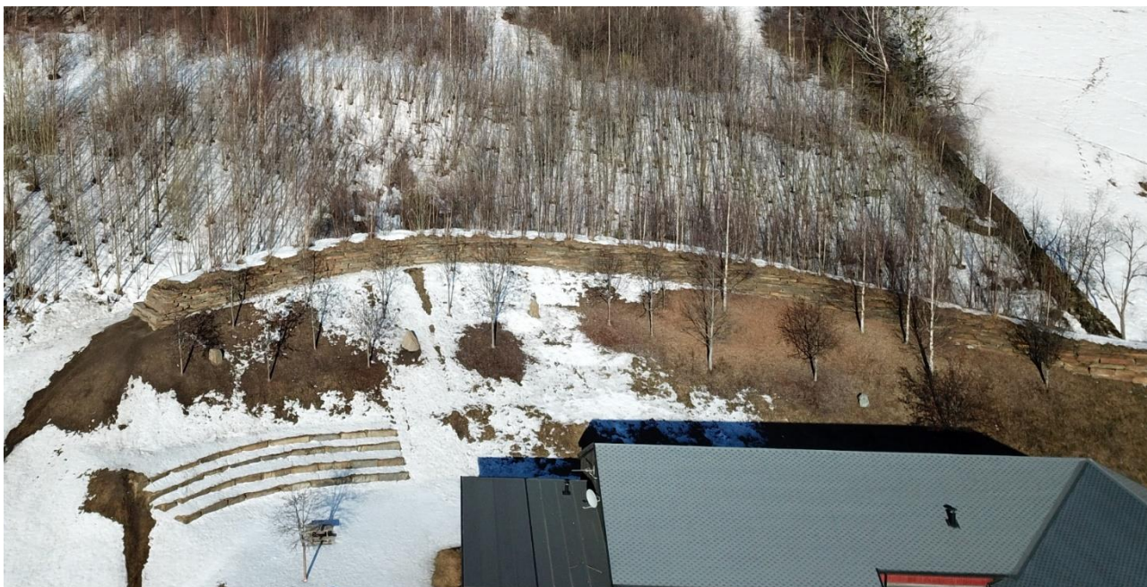
Figur 6. Det er bygd en fangvoll like ovenfor dagens barneskole. Foto: Per Ivar Dahlum.
