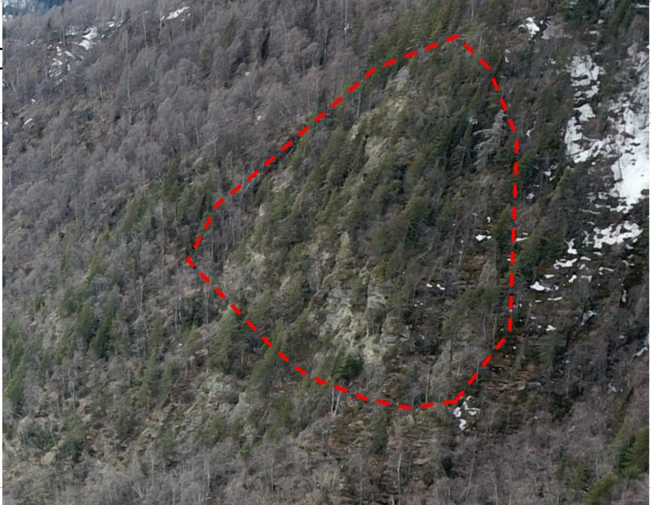
Figur 12. Viser en av skrentene like over kote 550.
