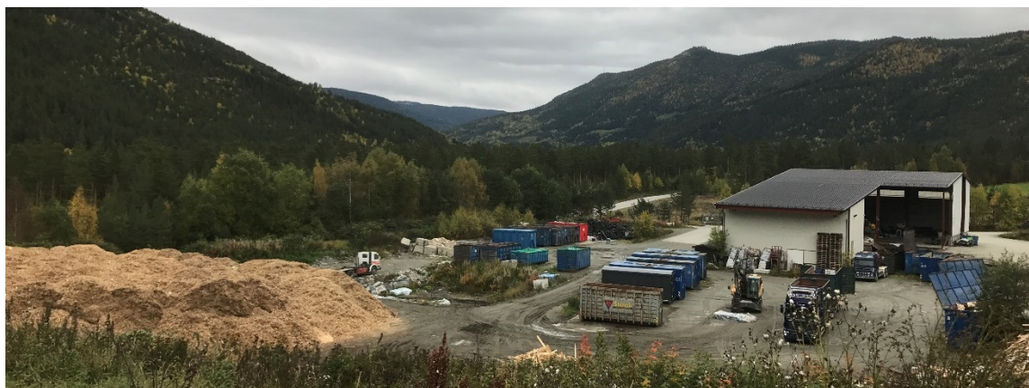
Figur 1. Bildet viser NGR sitt hovedanlegg for omlasting og sortering. Foto: Norconsult
